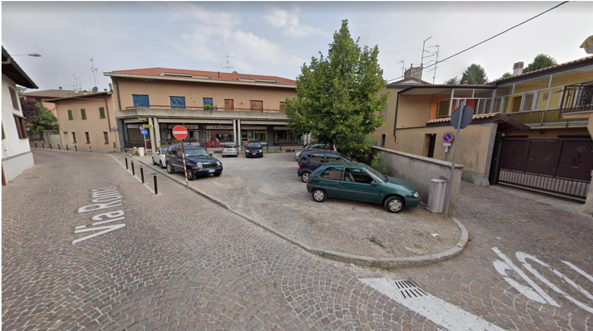
Area di sosta in prossimità dell'ufficio postale di via Roma
